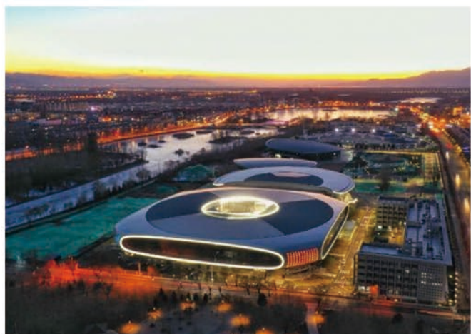
北京冰上项目训练基地
