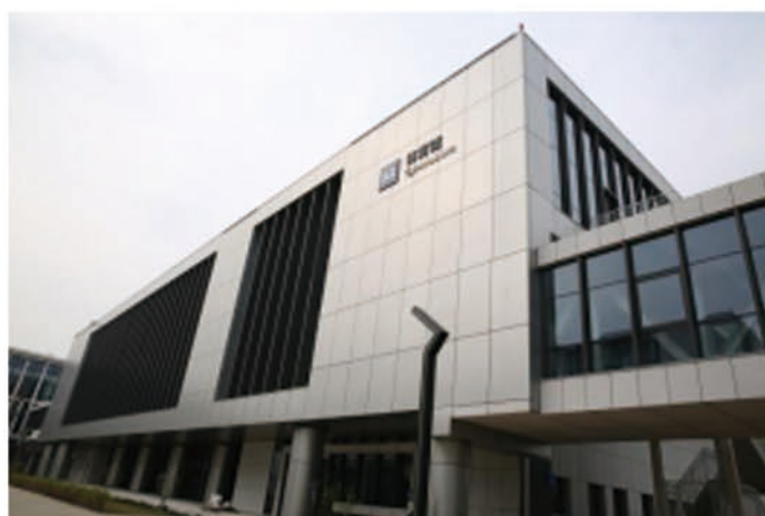
大兴机场教育科研基地体育馆
